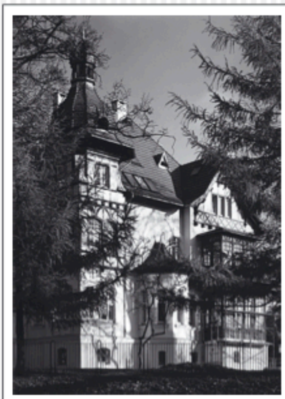
Willa przy ul. Solskiego 3, 2002 Die Villa am Eichendorffweg 3, 2002
